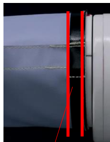
ズレないようにしっかりと合わせ 「面ファスナー」で固定していきます
