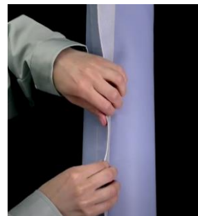
「外付き摺動シート」が 一直線になるように合わせます
